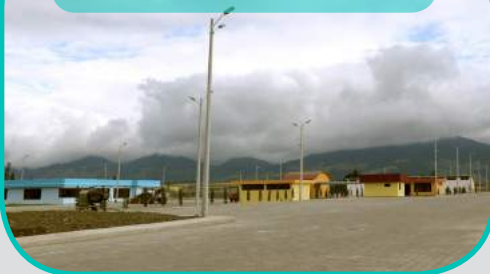
Acceso a la parte interna
